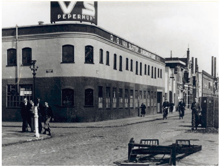
Bijschrift De Suikerwerkfabriek op de Emmakade noordzijde/ hoek Rembrandtstraat in 1945. (Foto's: HCL)
